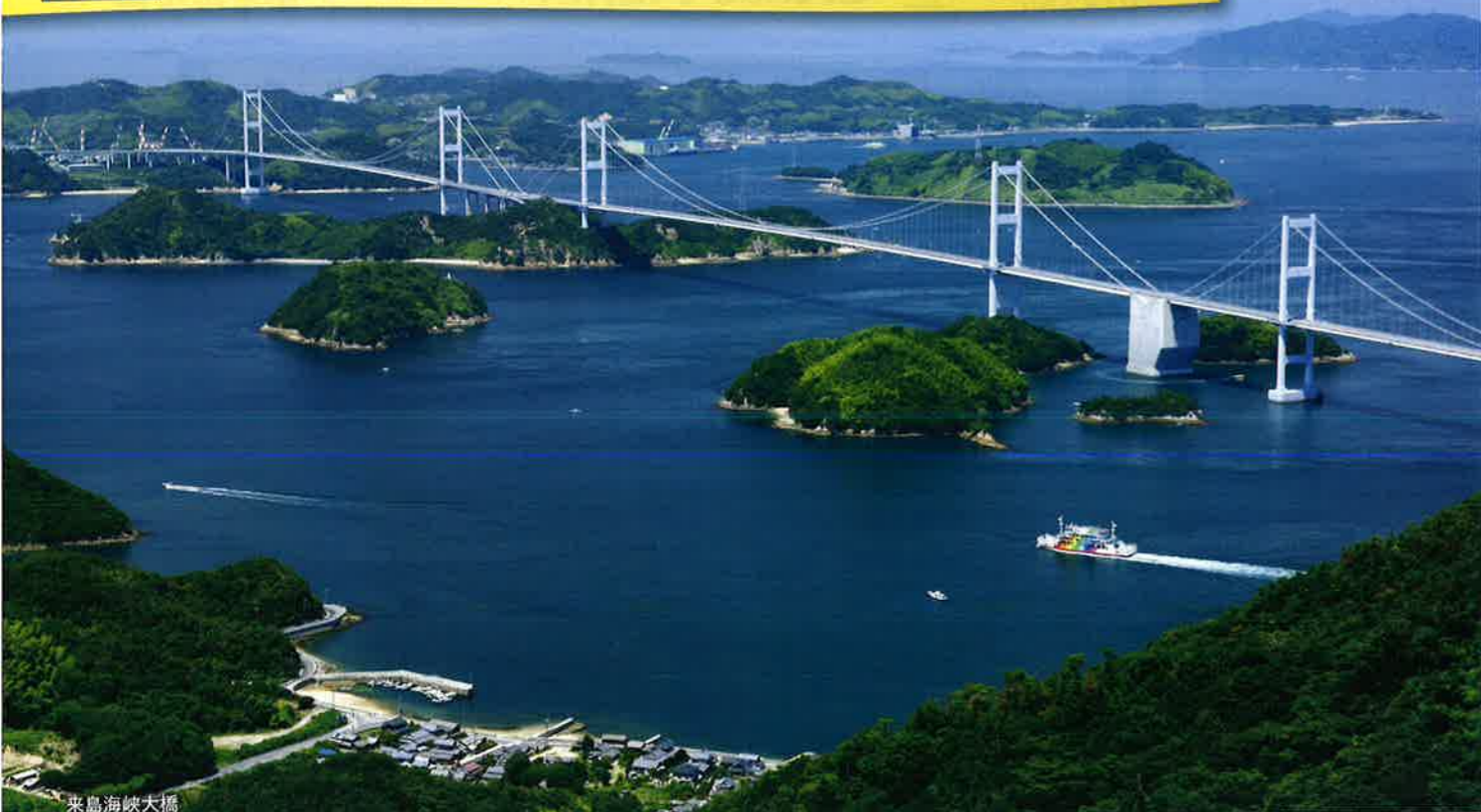
来島海峡大橋
