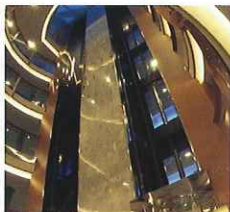
エレベーター
