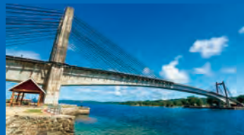
日本・パラオ友好の橋(パラオ)
